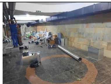
Будівельні роботи на станції метро «Університет».
